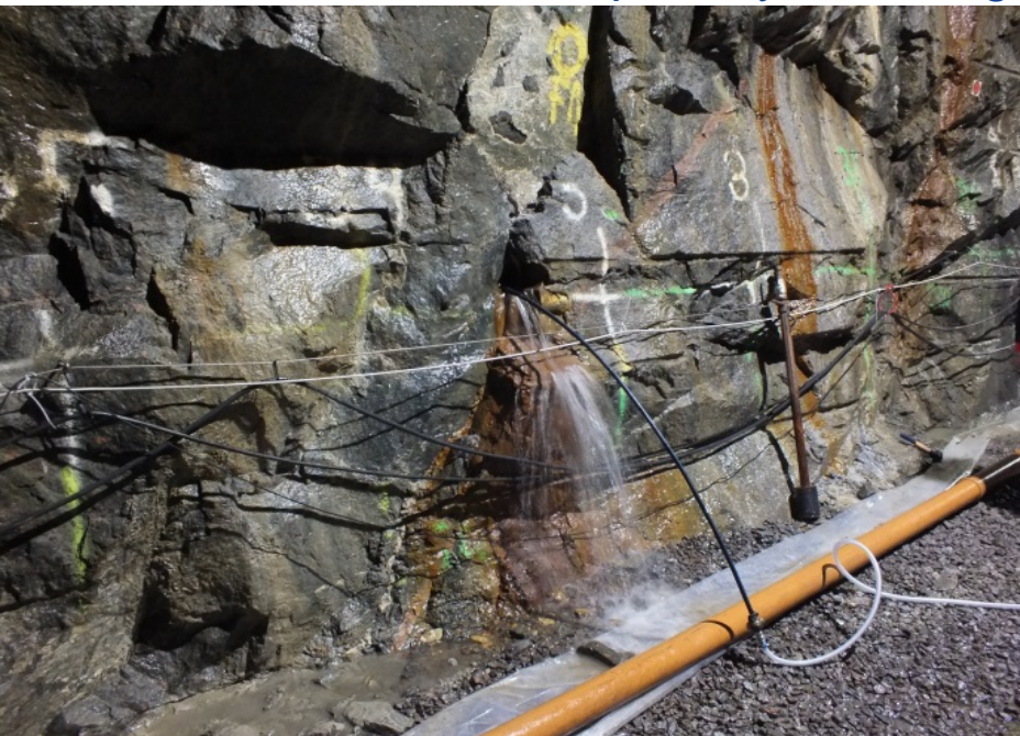
(a) Flushing borehole F1
