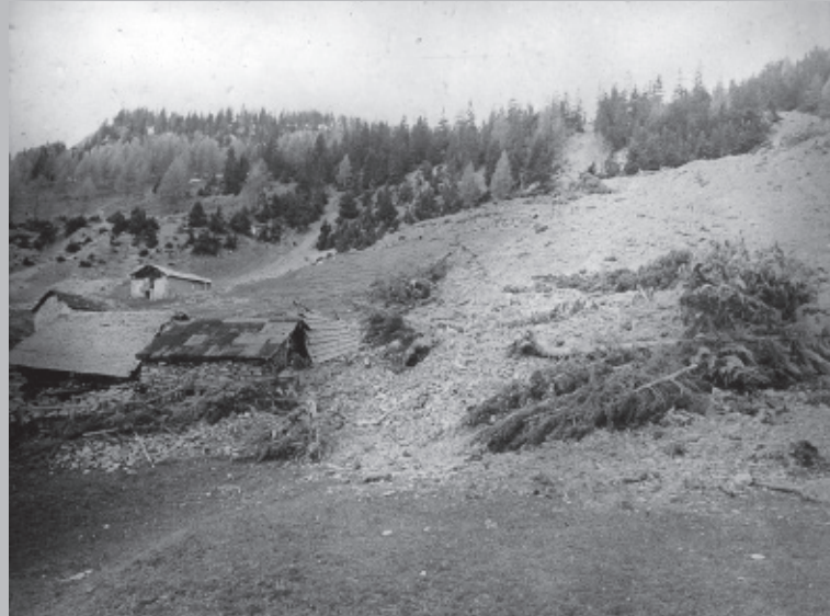
Viele Strassen wurden von durch das Beben ausgelösten Lawinen und Felsstürzen unterbrochen. Derartige Unterbrüche würden die Wirtschaft im Wallis heutzutage für einige Monate stark beeinträchtigen.
