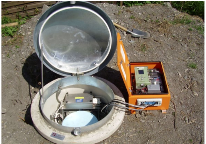
Geöffnete Abdeckung einer Freifeld-Installation
