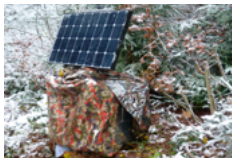
Station sismologique temporaire fonctionnant à l'énergie solaire près du projet géothermique de Saint-Gall
